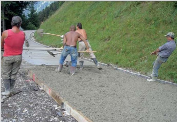
Betoneinbau: Abziehen mit Vibrobalken
