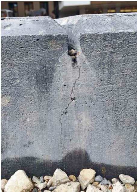
Abb. 5: Scheinfuge mit Voute und geplantem Riss
