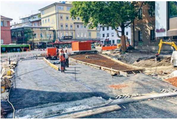
Abb. 2: Unterbau (Asphalttragschicht)
