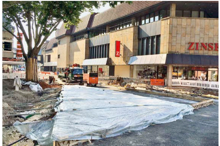
Abb. 10: Einpacken der Betonflächen mit Folie (Nachbehandlung)
