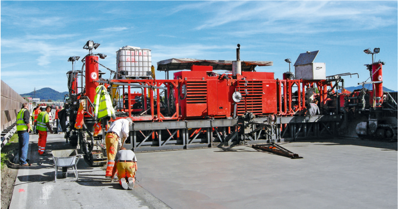
Abb. 7 Betondeckeneinbau bei Tag
