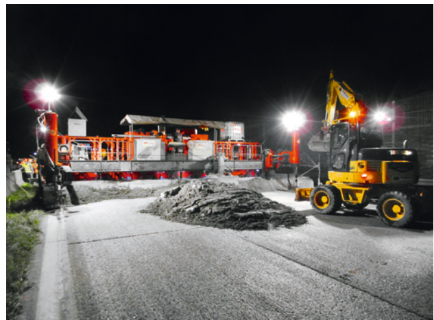
Abb. 8 Betondeckeneinbau bei Nacht
