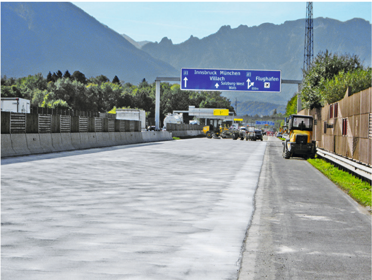
Abb. 9 Fertig sanierte Betondecke
