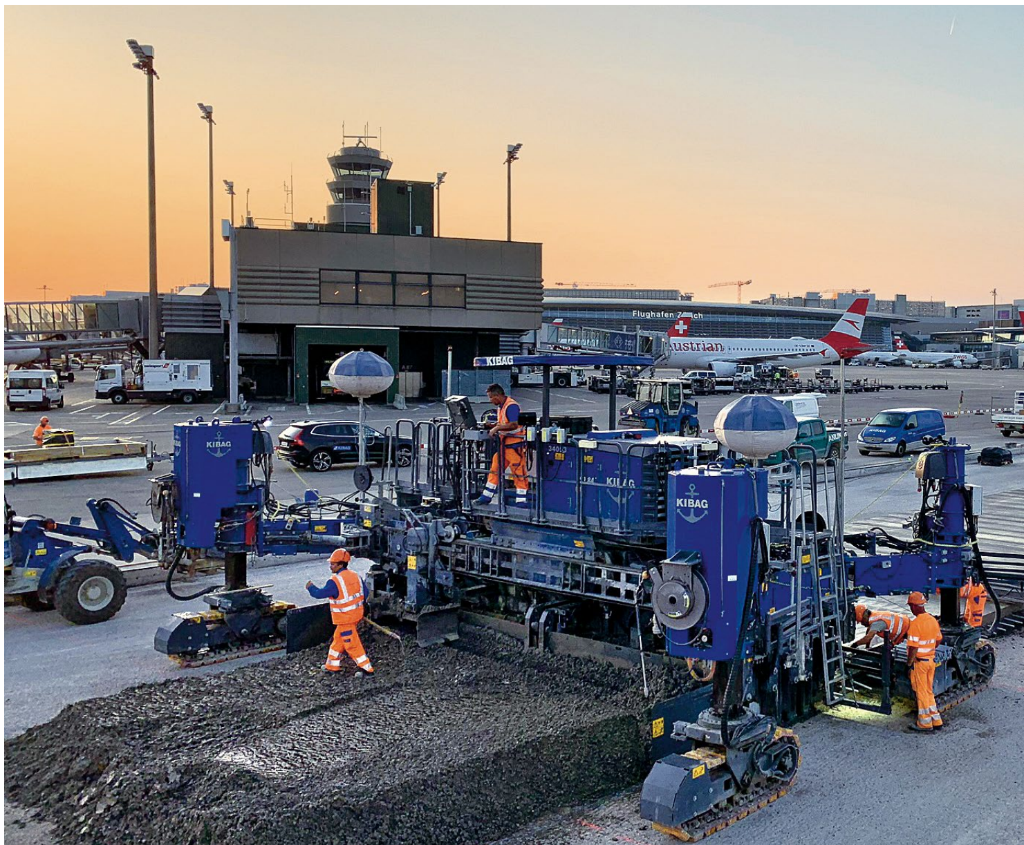
Einbau der Stehbahn
