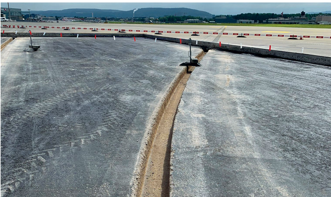
Graben für die Verlegung der Rolllinienbefeuerung
